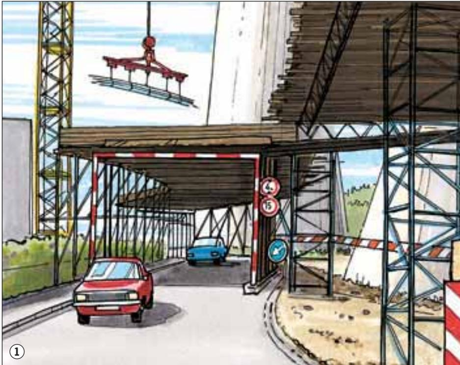
Gefahrenbereiche in der Nähe turmartiger Bauwerke oder höher gelegener Arbeitsplätze so absperren, dass unbewusstes Betreten verhindert wird. Lässt sich der Gefahrenbereich nicht absperren: Schutzdächer oder Schutznetze vorsehen. Sie sind anzubringen ...
