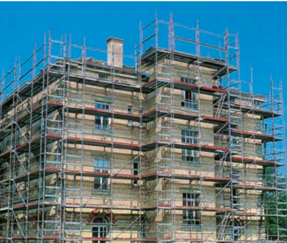
Fassadengerüst an stark strukturierten Fassaden
