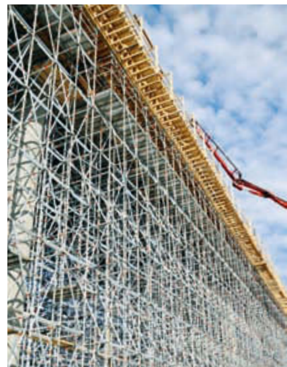
Traggerüst in Industrie-, Brücken- und Massivbau
